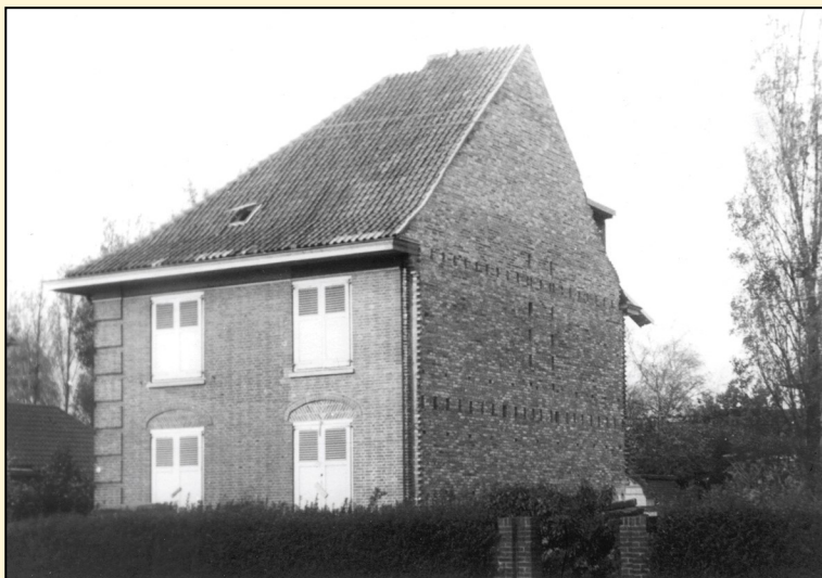
Het pand Parklaan 31, dat bij het bombardement op 1 september 1943 alleen overbleef, werd in 1944 provisorisch dicht gemaakt en na de oorlog in oude luister hersteld. Foto J. Sturm, Roosendaal, collectie West-Brabants Archief.
