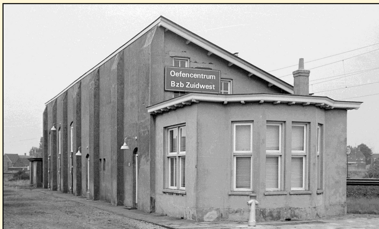
Het na het bombardement in 1943 overgebleven deel van de voormalige HIJSM-loods bleef nog 55 jaar in gebruik. Duidelijk zijn de steunberen voor de stalen spantenconstructie te zien. In het voorste deel had destijds de werkmeester van de HIJSM zijn kantoor. Foto Marius Broos, 7 oktober 1973.
